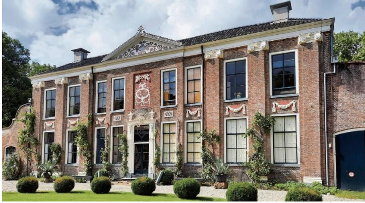
De gerestaureerde gevel van havezate Oldengaerde in Dwingeloo. foto's het Drentse Landschap / Sake Elzinga
