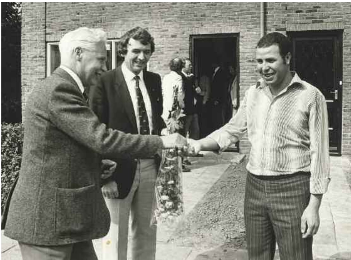
Op 23 juni 1981 werd de eerste gerenoveerde woning in de Dichtershof opgeleverd. Hoofdingenieur-directeur Volkshuisvesting in Drenthe ir. J. de Vries overhandigt de sleutel aan dhr. Errabi, de bewoner van Bilderdijkstraat 1.
