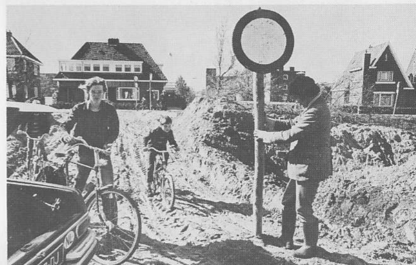
Dam over het Noord-Willems Kanaal
